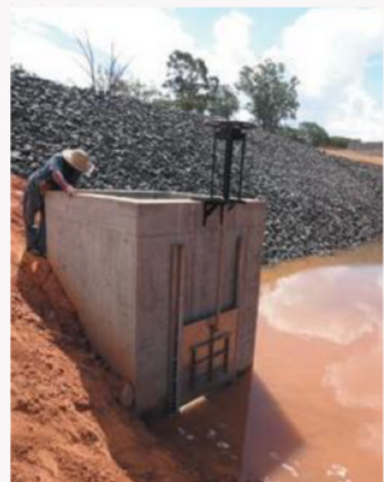
Contenção de Alagamento
